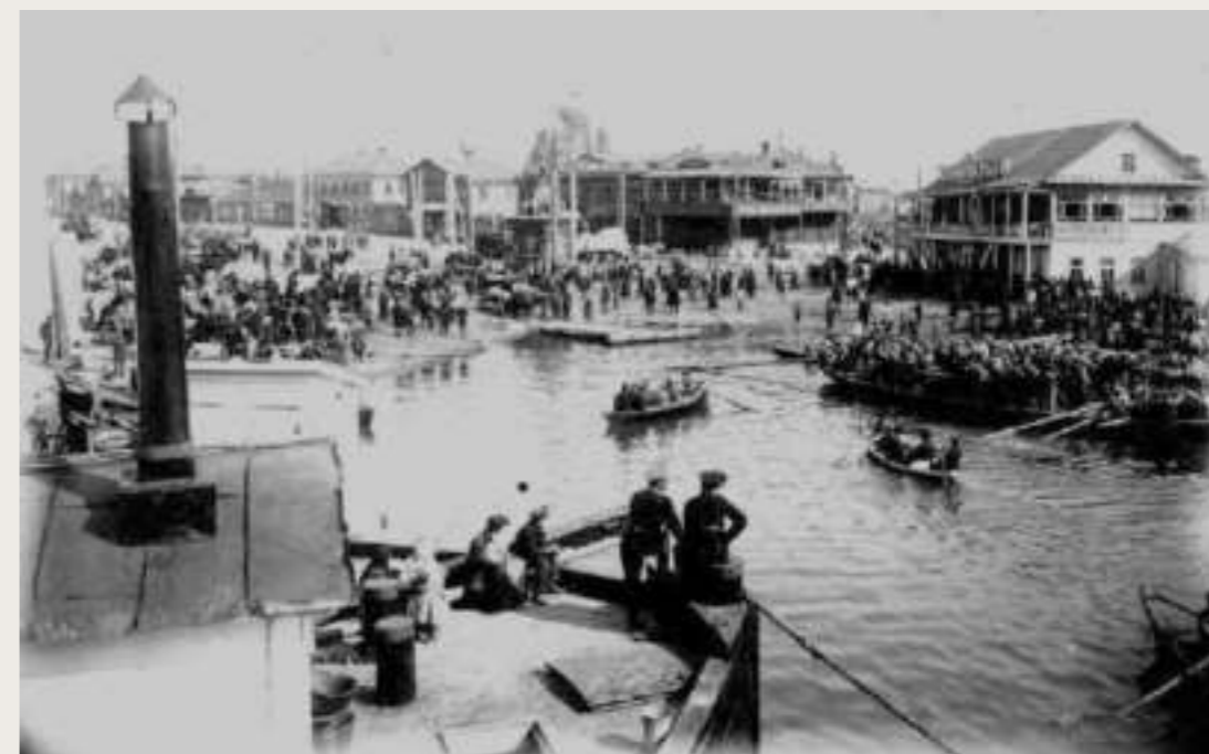
Весенняя пристань, возведенная в Петровский период Источник: Историческая справка ООО «НПФ «Рекон+»
